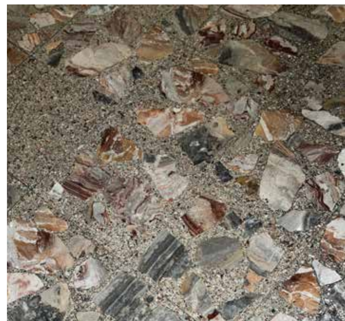
测量公共区域内水磨石铺设的面积
